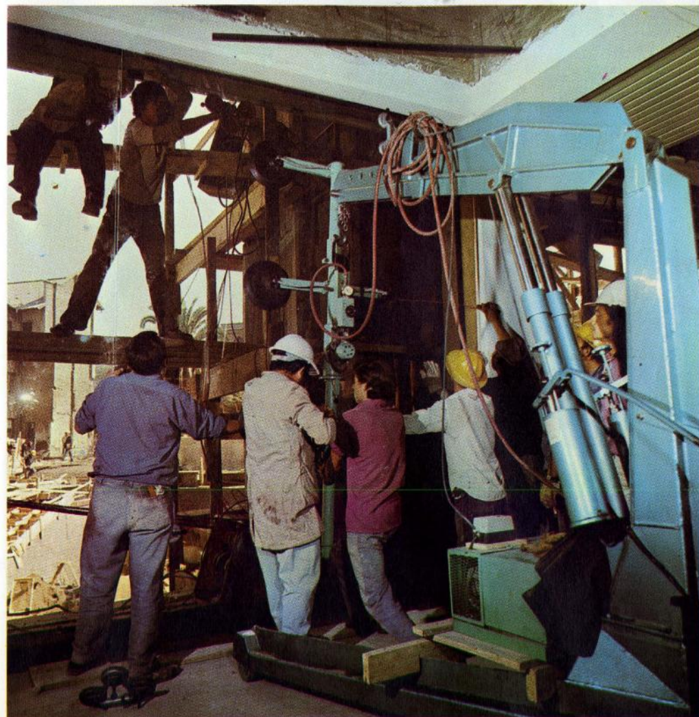
Colocación de uno de los Cristales Atórmicos Bronce "spectrafloat" del edificio UNCTAD III.
